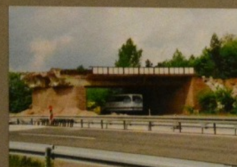
April 2000, KW Ve, Abriss Kohlebrücke B115+A15
