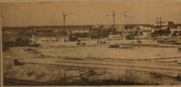
Der verströmte Kiefernwald, machte weiches und machte einer riesigen Baustelle Platz. Heute wird hier ein Kraftwerk gebaut!
