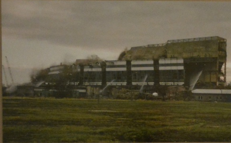
16.12.2003, Sprengung Hauptgebäude Werk V
