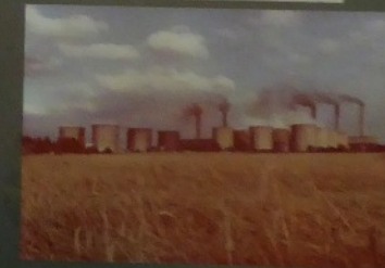
Großversuchsanlage - Rauchgasentschwefelung (GVA-RGE)/Absorbergruppe mit Rauchgaskanälen am 20.12.1968 ( Probetrieb Rauchgasstraße )
