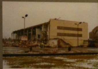
Jan. 1999, KW Ve, Betriebsgasstätte Rückbau
