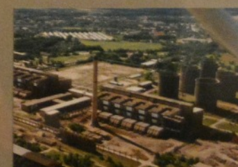
Juni 1997, KW Ve, vor letzter Schornsteinsprengung 02
