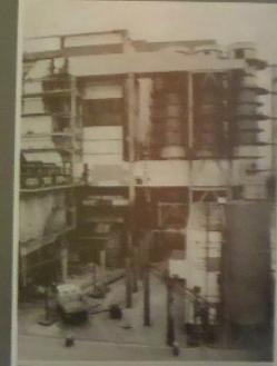
Großversuchsanlage - Rauchgasentschwefelung (GVA-RGE)/Absorbergruppe mit Rauchgaskanälen am 20.12.1968 ( Probetrieb Rauchgasstraße )
