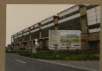
Mai 2009, KW Ve, Rückbau Werk IV
