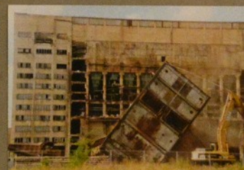
2003, KW Ve, Werk V Kessel 7 gesprengt
