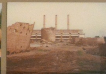
Juni 1996, KW Ve, Werk IV Rückbau Kühltürme
