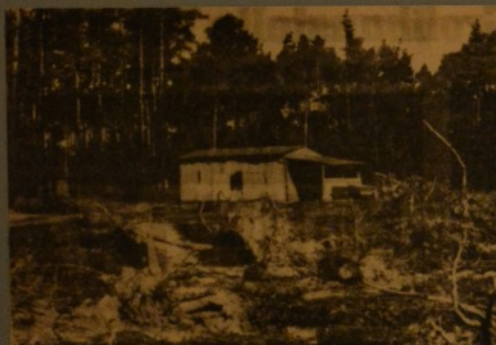
Baustelle Kraftwerk Vetschau September 1959
