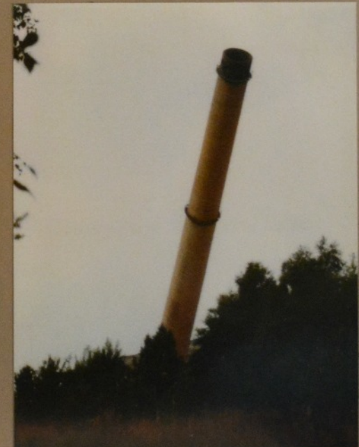
17. Juli 1997 Vetschau, Sprengung Schornstein 5
