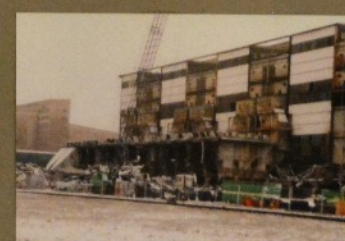
April 2003, KW Ve, Werk V Rückbau E-Filter
