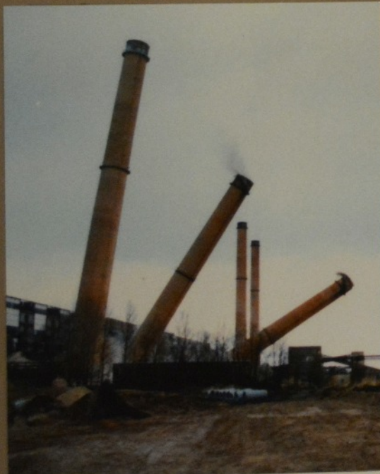
21. November 1996 Vetschau, Sprengung Schornstein 1-3
