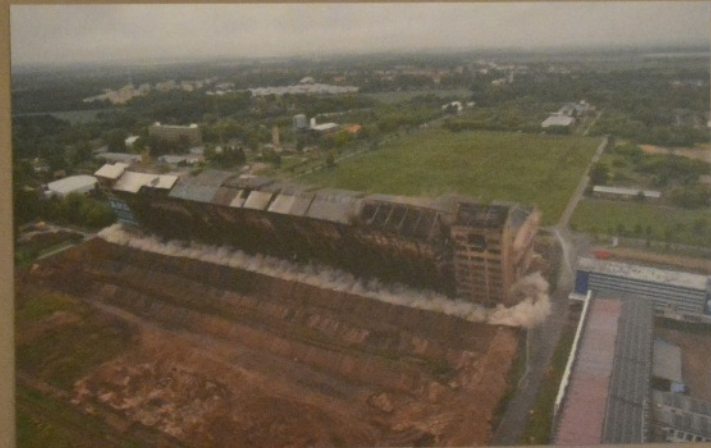
26.5.2013, Sprengung Hauptgebäude Werk IV
